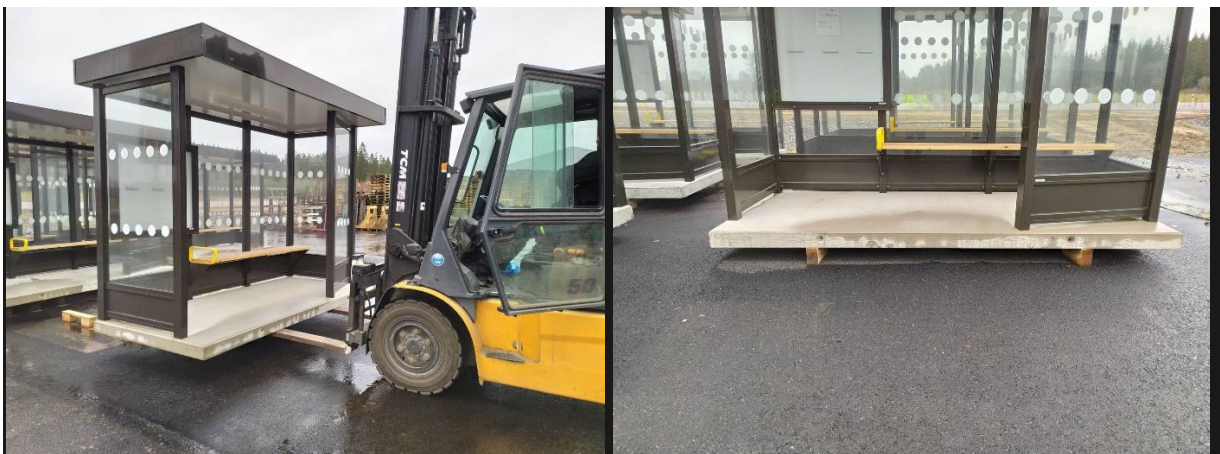
Bild 4. Lyfts med vanligt gaffelstativ med gafflarna så brett isär som möjligt.
