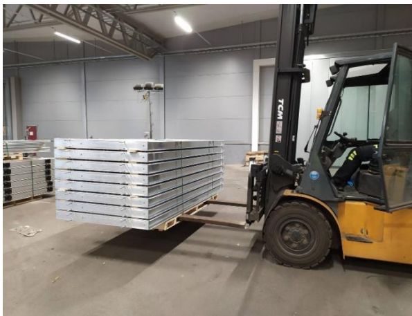
Bild 2. Balkongplattor kommer packade på långpall som är balanserad. Lyft med vanligt gaffelstativ på truck eller hjullastare med gafflarna så brett isär som möjligt.
